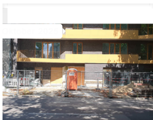
Baustelle in Berlin-Moabit (Foto A. Pfuhl)
